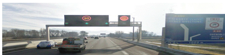
Figure 5 : PPP signalant le dispositif de VSP (dispositif non activé)
